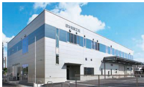
NDK新潟ビル (日本電設工業株式会社)
